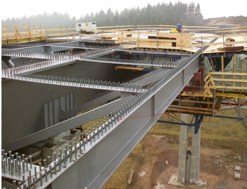
Gambar 4 : Jembatan komposite dengan penghubung geser.
