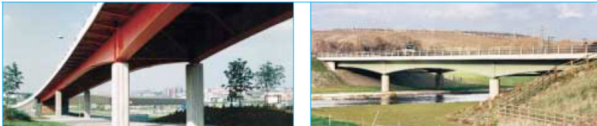
Gambar 2 : Jembatan komposit, gelagar kotak.
