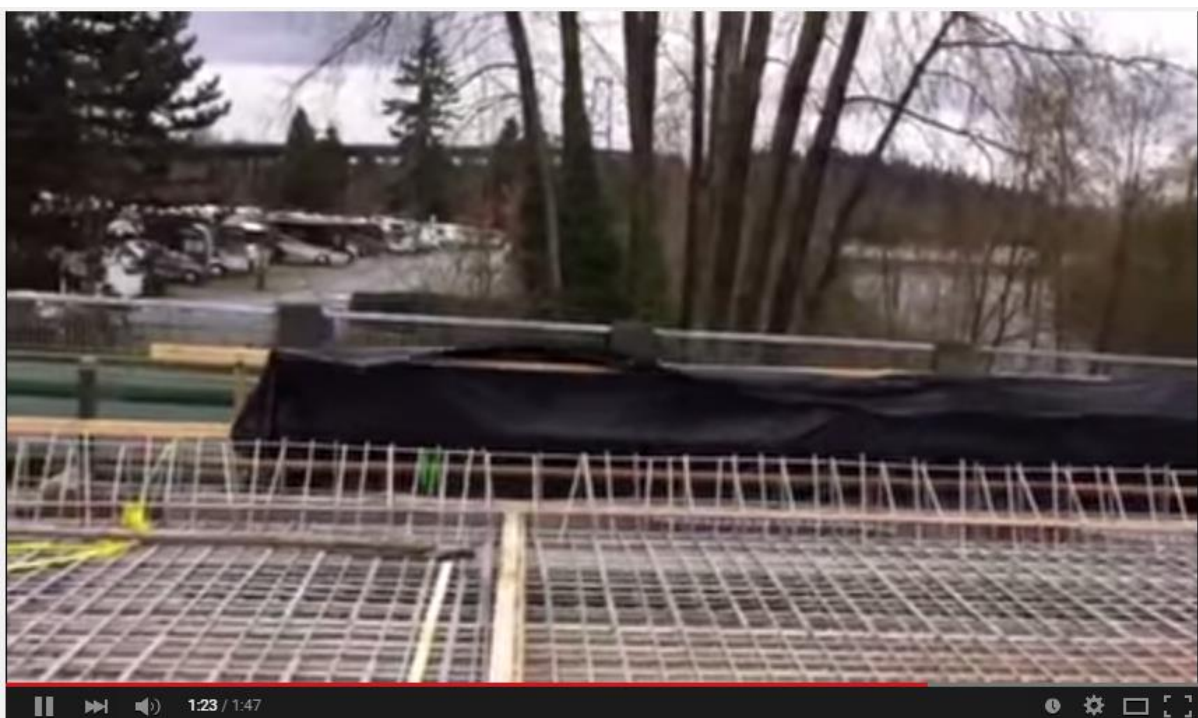
Gambar 12 : Tulangan parapet
